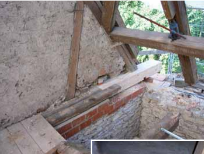
Während der Reparatur der stark geschädigten Traufpunkte. (Sept. 2006)
