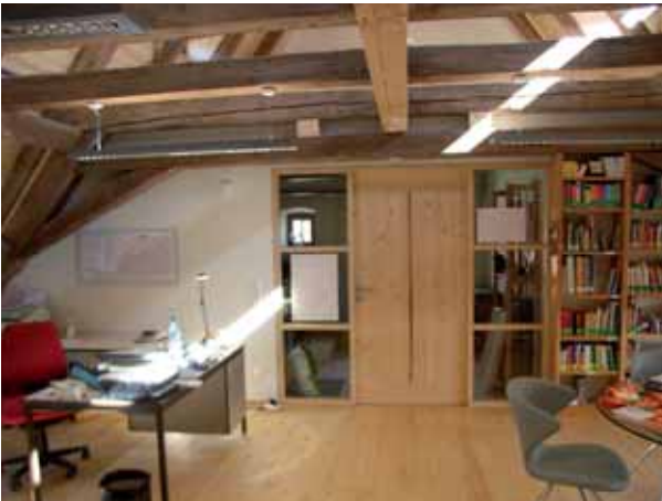
o. Spitzboden mit Hahnenbalkenlage u. Blick in ein Büro
