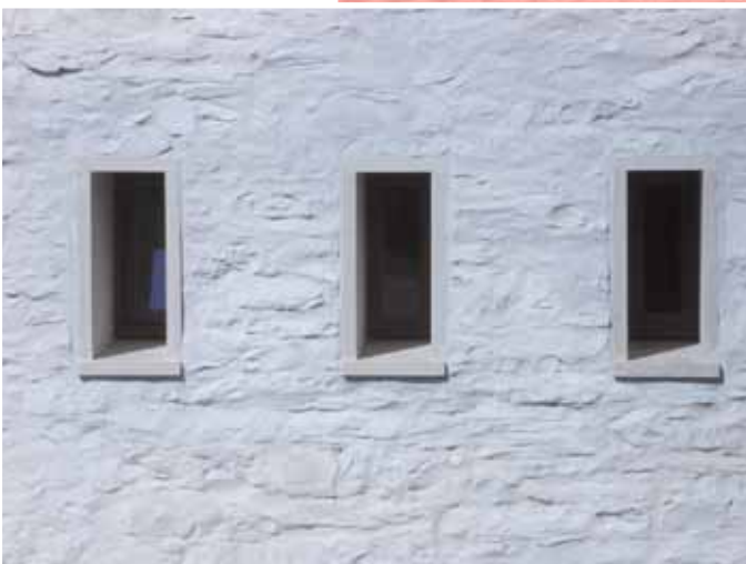
Die Schießschartenfenster der Nebenräume (WC's) (April 2007)
