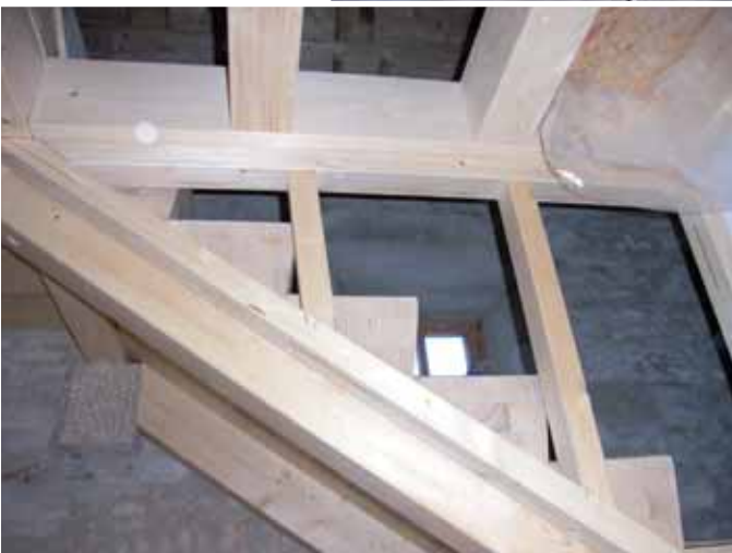
Während der Montage der neuen Treppenanlage. (Dez. 2006)
