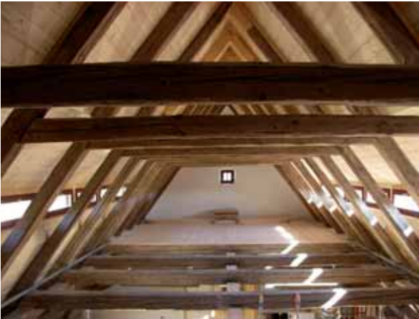
o. Spitzboden mit Hahnenbalkenlage u. Blick in ein Büro
