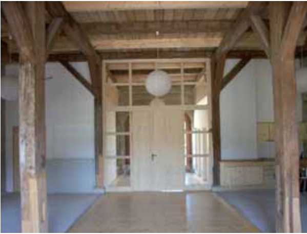
o. Blick vom Saal zum Foyer
